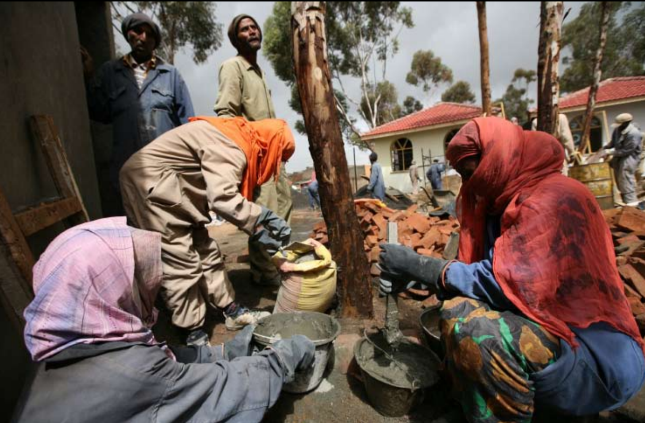
In Eimern rühren Frauen den Putz an und streichen ihn auf die Wände..
